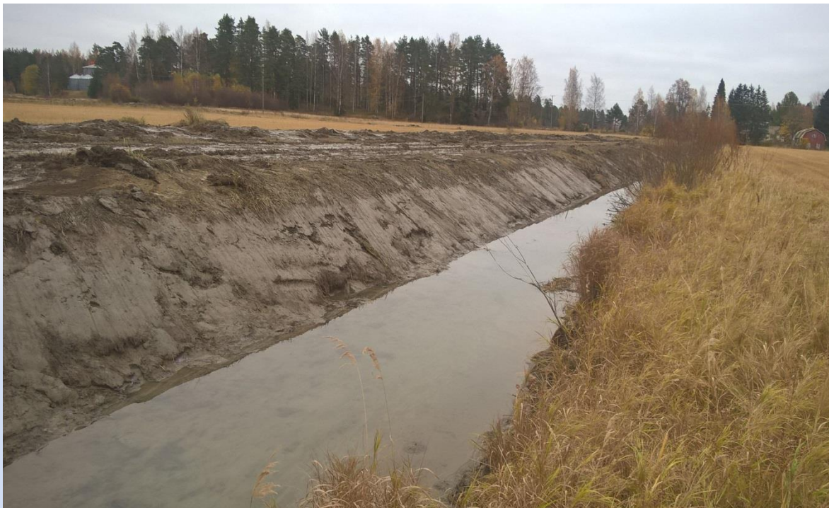
Toispuoleinen varovainen kaivu
